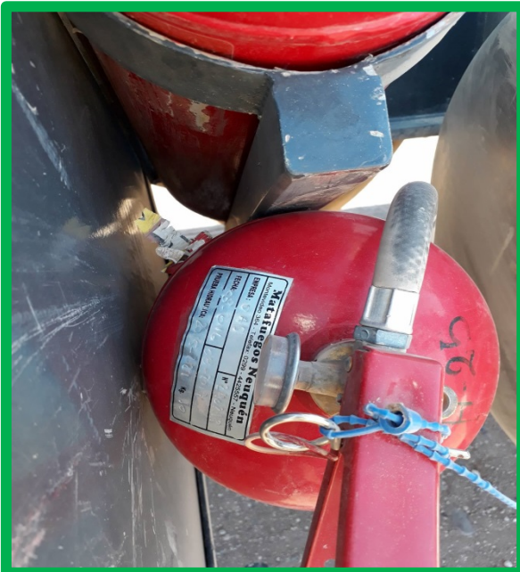
11. Extintores de montaje vigentes y cargados. Tiene precinto azul, para evitar que se descarguen
